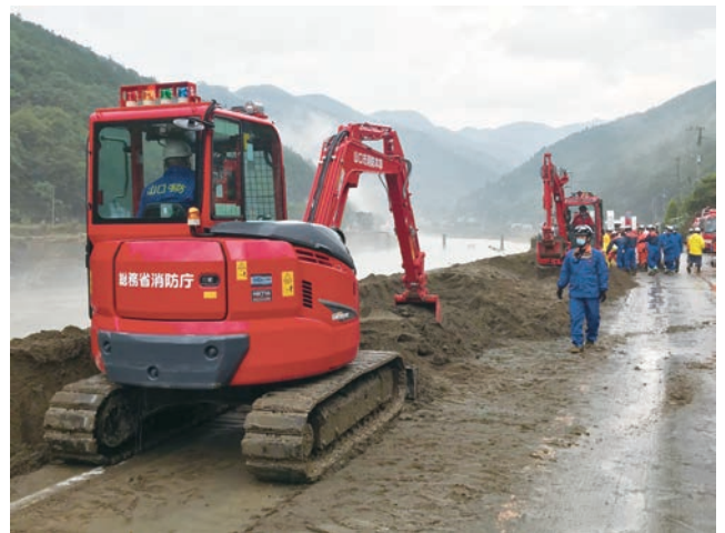
重機を活用した搜索活動（熊本県球磨村） （下関市消防局提供）
