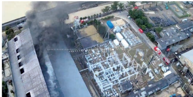
消火活動（熊本県芦北町） （福岡市消防局提供）
